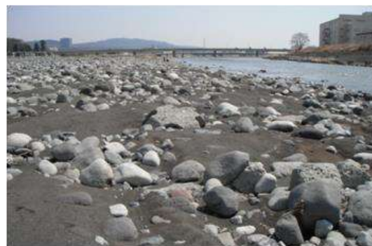
土砂が堆積した河川
