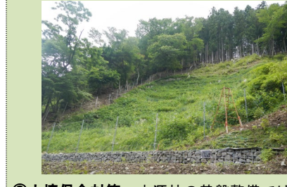
③土壌保全対策 水源林の基盤整備では土木的工法を用いて土壌保全対策を実施した。(山北町世附)
