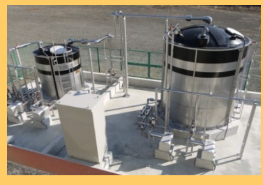
⑨相模川水系上流域対策 山梨県内の下水処理場に設置したリンを取り除くための設備を稼働した。(山梨県桂川清流センター)
