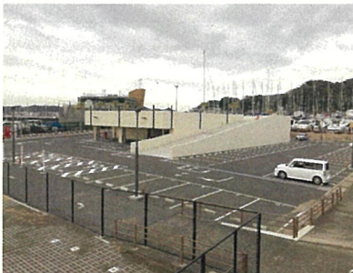
F 臨港道路附属駐車場
