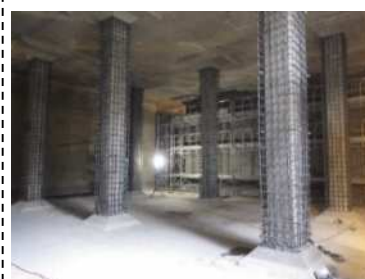
<配水池耐震化工事>
