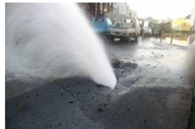
近年県営水道で発生した漏水事故
