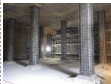
<配水池耐震化工事>
