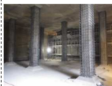
<配水池耐震化工事>
