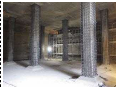
<配水池耐震化工事>
