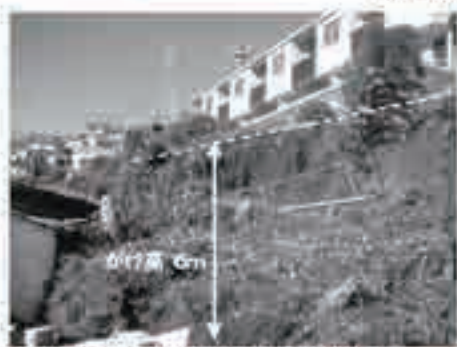
住居エリアに隣接した高さ10m未満の急傾斜地
