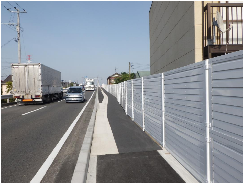
(6) 南側区間完成供用済み歩道の状況
