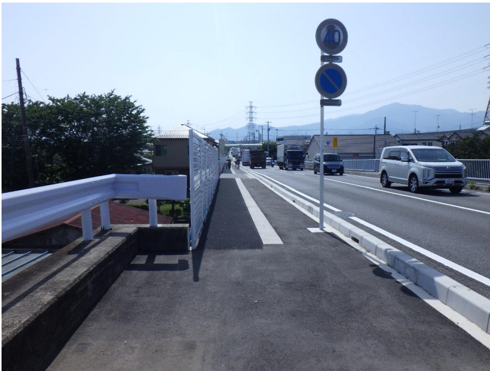
(2) 戸沢橋側から戸田交差点方面の状況
