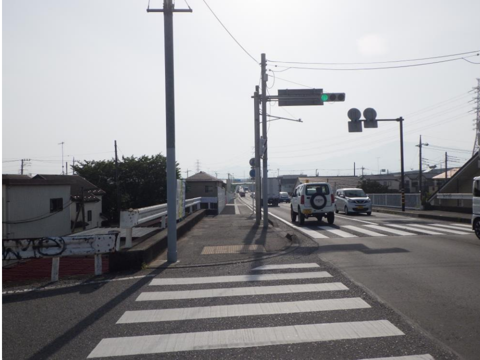
(3) 戸沢橋側から戸田交差点方面の状況
