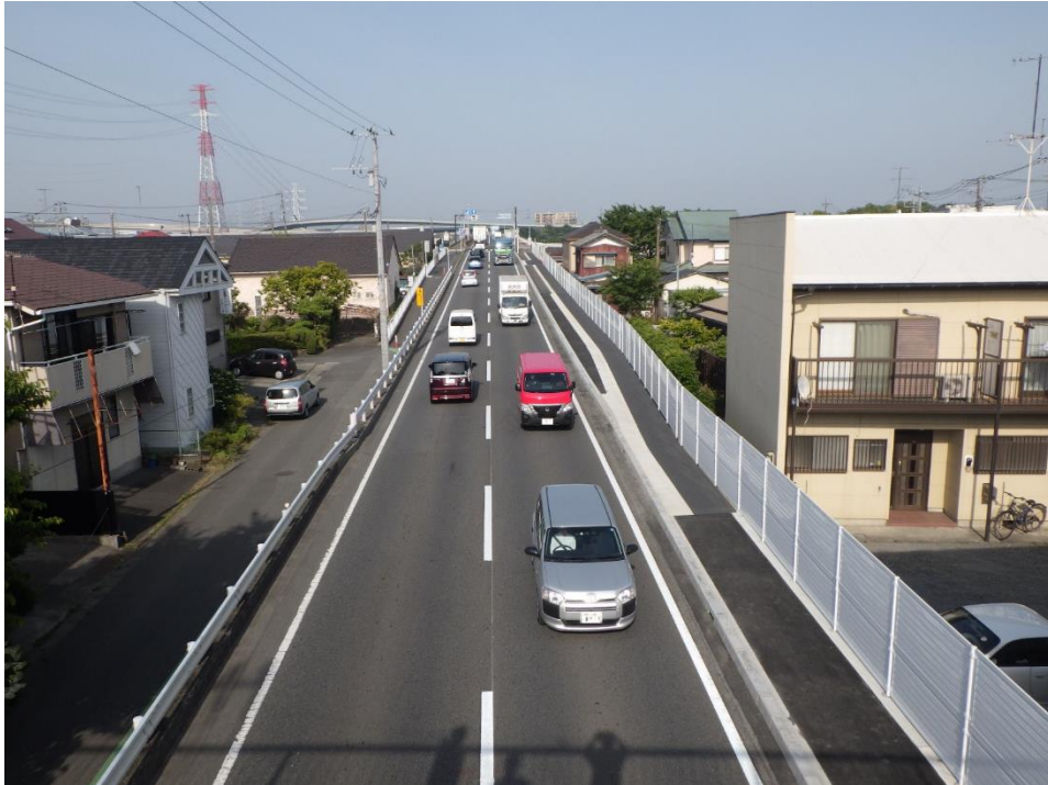
(5) 上戸田歩道橋上部から戸沢橋方面の状況
