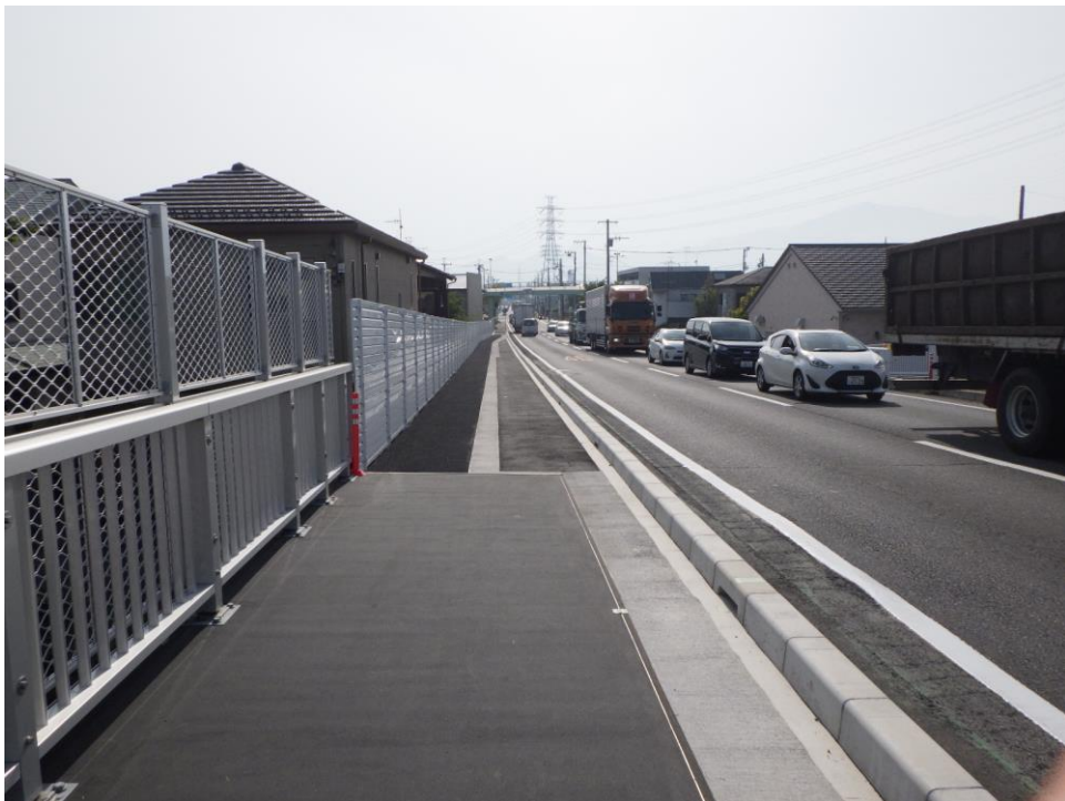
(4) 南側区間完成供用済み歩道の状況
