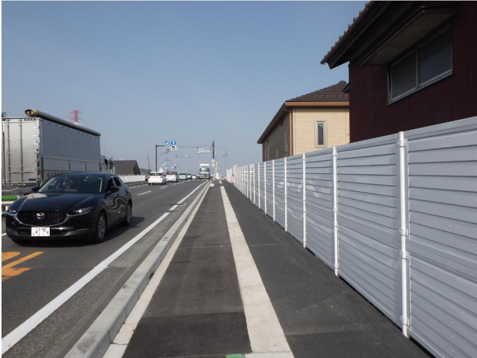
(7) 南側区間完成供用済み歩道の状況
