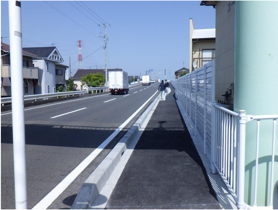
(1) 上戸田歩道橋下部から戸沢橋方面の状況
