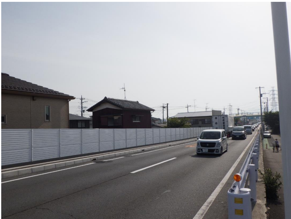
(8) 南側区間完成供用済み歩道の状況
