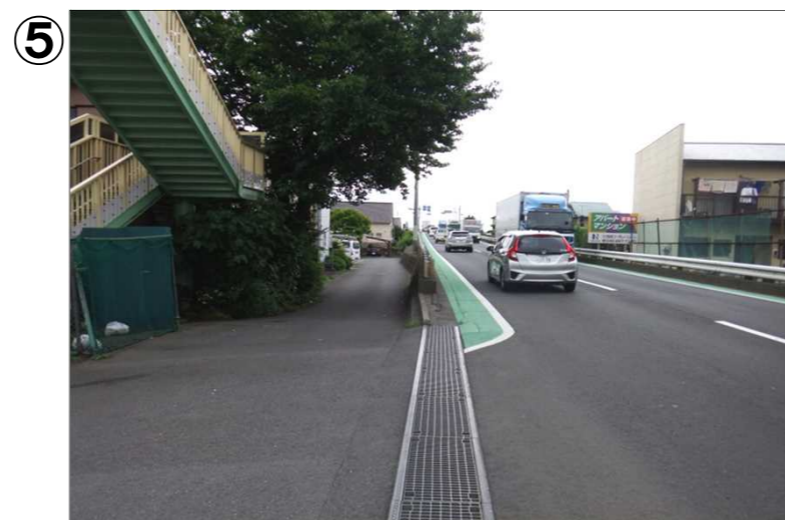
⑤ 伊勢原側(上戸田歩道橋)から側道部を望む
