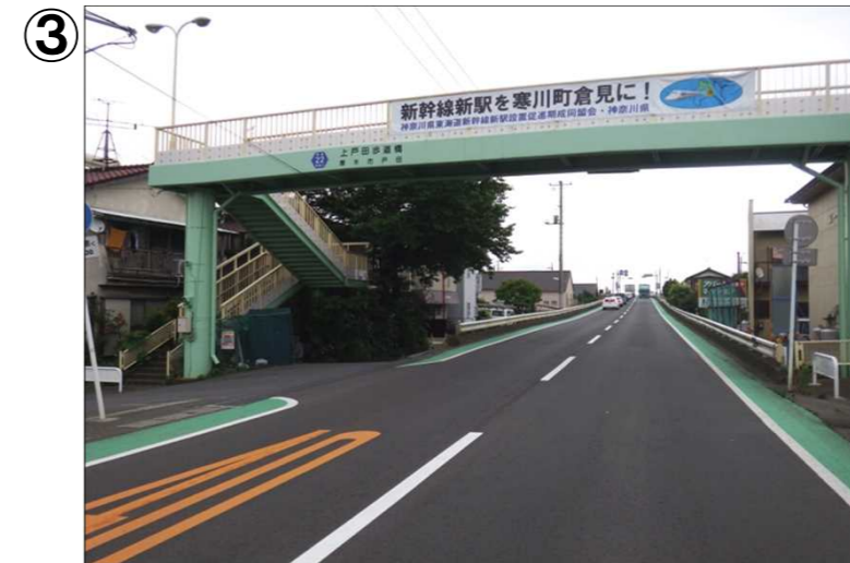
③ 伊勢原側(上戸田歩道橋)から海老名側(戸沢橋方向)を望む
