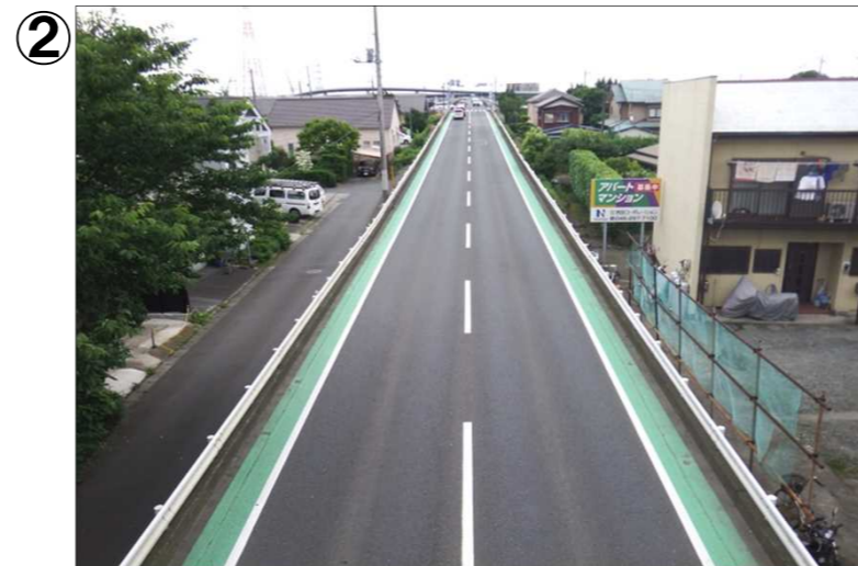
② 伊勢原側(上戸田歩道橋上)から海老名側(戸沢橋方向)を望む
