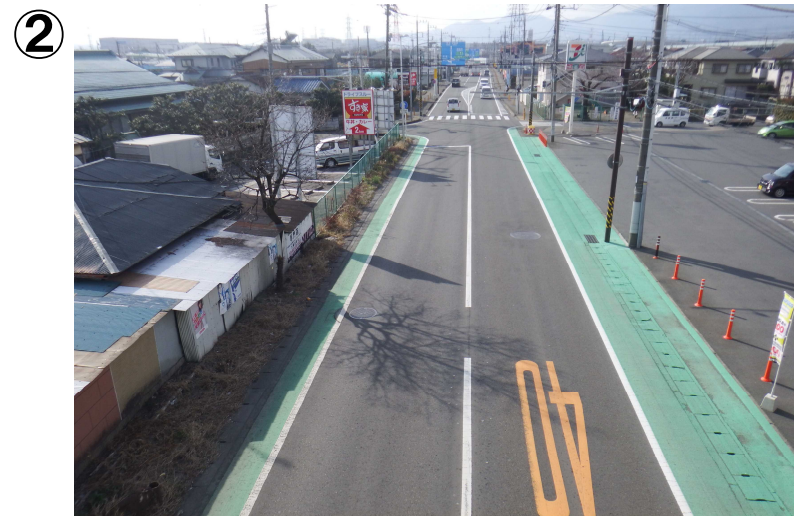
海老名側(上戸田歩道橋上)から伊勢原側(戸田交差点方向)を望む
