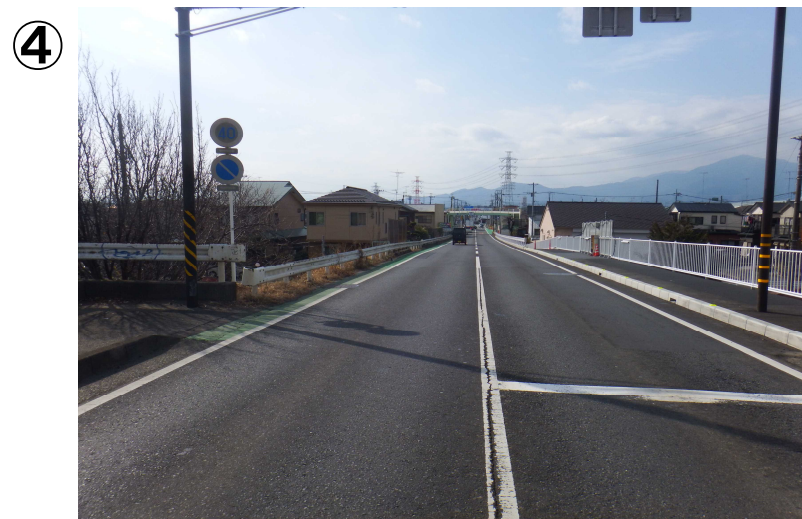
戸沢橋西交差点から伊勢原側を望む
