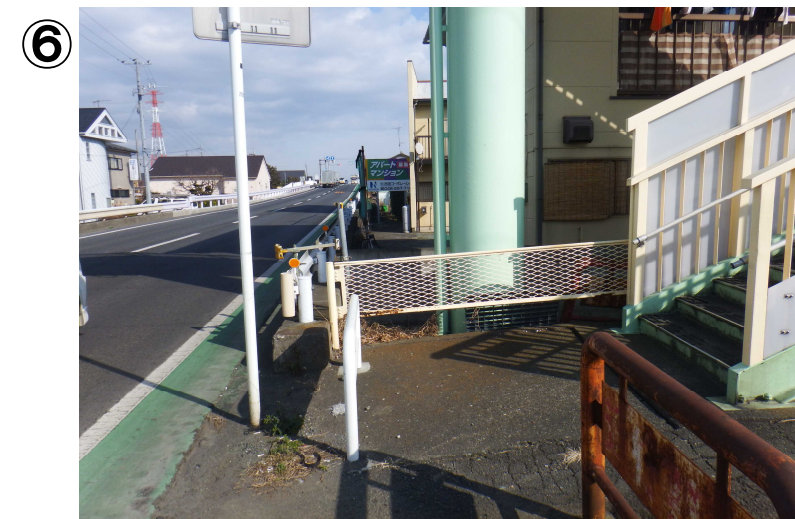
伊勢原側(上戸田歩道橋下)から海老名側(戸沢橋方面)を望む(南)
