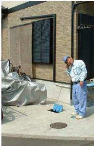
宅地内の漏水調査の様子
