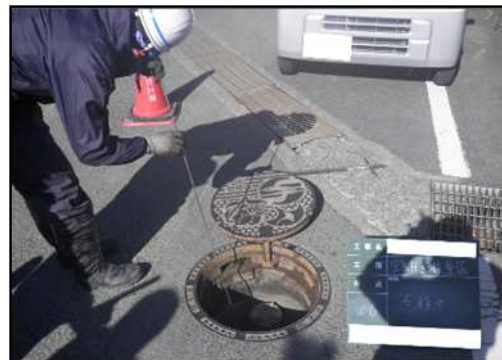
目視・音調により異常がないか点検している
