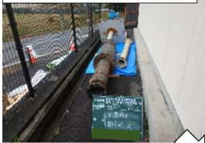
撤去したポンプ(水中ポンプ 55kW)
