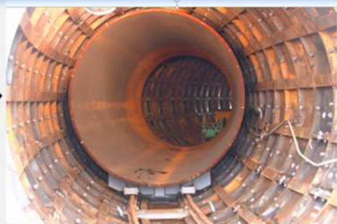
水道管を中に押し込む
