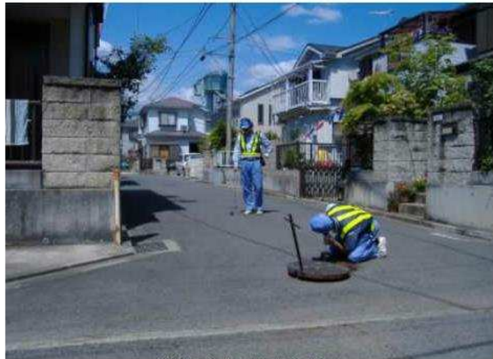
道路での漏水調査の様子
