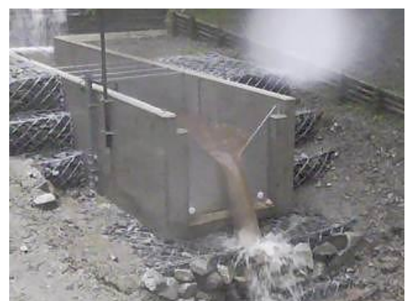
写真9 インターバルカメラで撮影した量水堰の状況 上/洪水前（濁っていない） 下/洪水時（濁っている）
