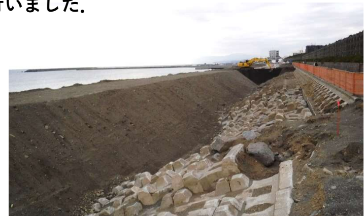
図2.3 2021年度の養浜工事の状況（養浜盛土活用）
