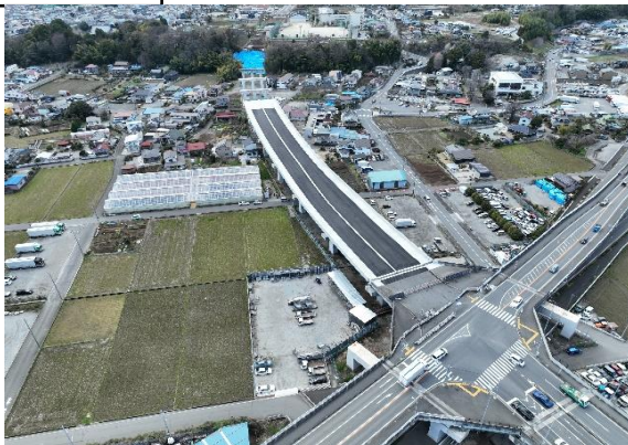
高架工区 (R6.3撮影)
