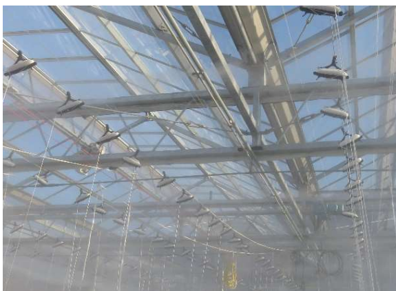
図 I-1-3 細霧発生装置による間欠噴霧 噴霧時間：20秒、休止時間：20秒
