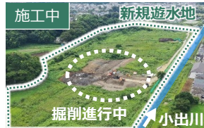
【R4】河川改修事業（小出川遊水地）
