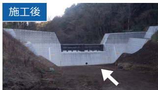
【R3】砂防堰堤工（玉川）
