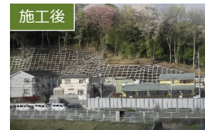
【R4】名瀬町栄橋（横浜市）
