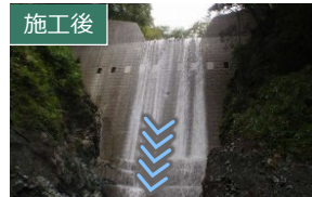
【R4】砂防堰堤工（菩提沢）
