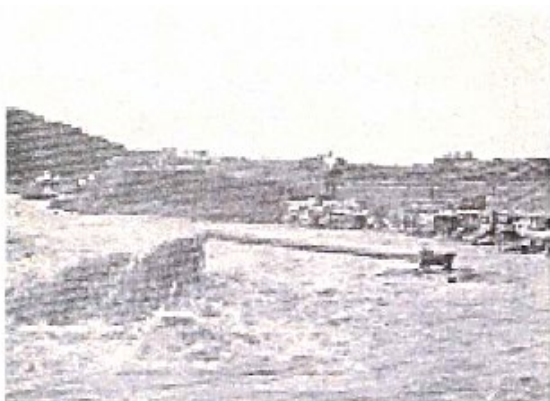
金目川水管橋付近 昭和36年6月の被害状況
