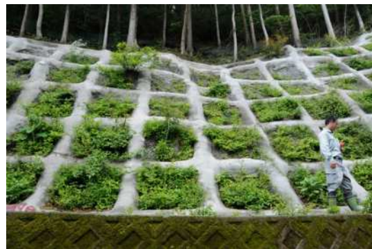
飛来種子捕捉マット施工地
