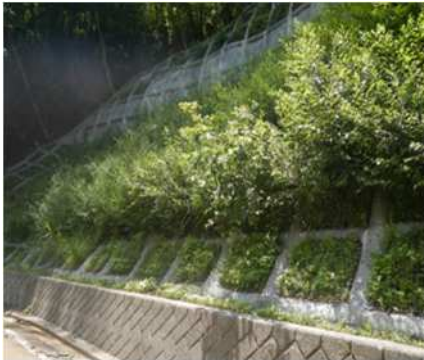
無種子の厚層客土吹付工施工地
