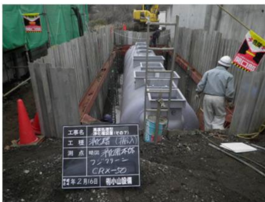
合併処理浄化槽の設置
