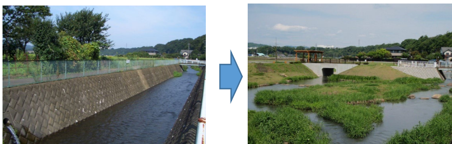
生態系に配慮した河川・水路整備（厚木市善明川）
