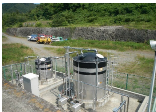
リン除去設備の設置 (山梨県桂川清流センター)
