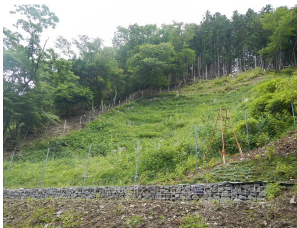
土木的工法（かご枠工）による土壤保全対策 土壤の移動が抑えられ植生が回復している状況
