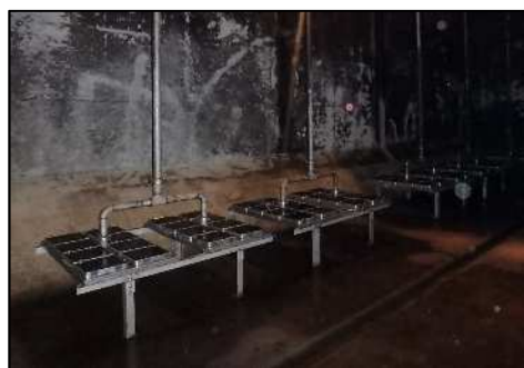
散気装置の改築更新（酒匂川流域下水道右岸処理場）
