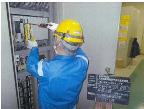
電気設備の点検の様子
