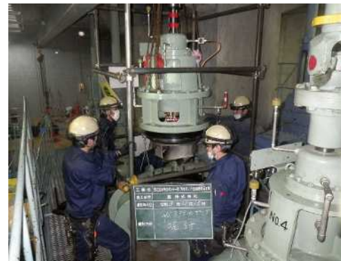
機械設備の修繕の様子
