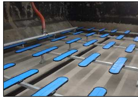
散気装置の改築更新（酒匂川流域下水道右岸処理場）
