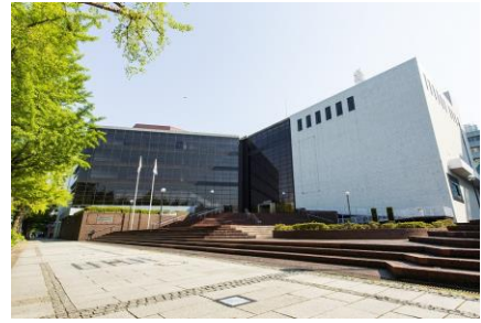
神奈川県民ホール外観
