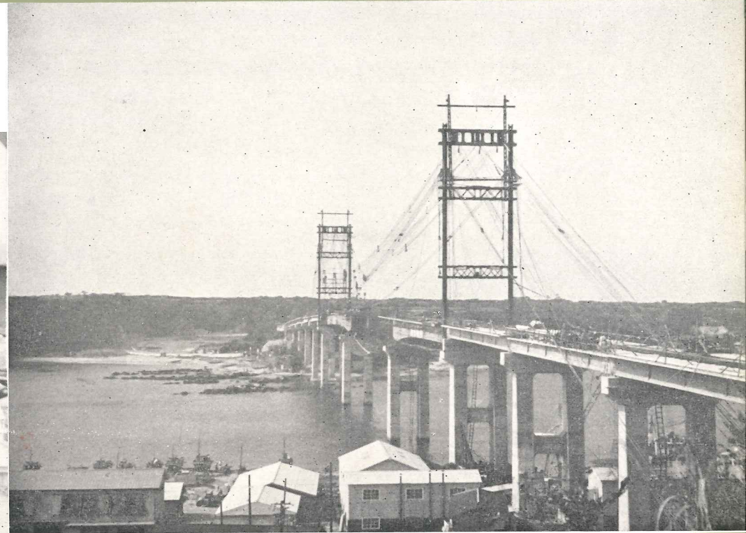
ボックスガーター架設
