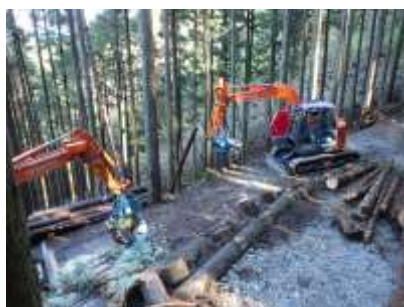
高性能林業機械を利用した 集材作業の様子
