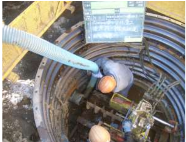
公共下水道の整備（相模原市）
