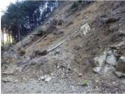
水源林の基盤の整備
