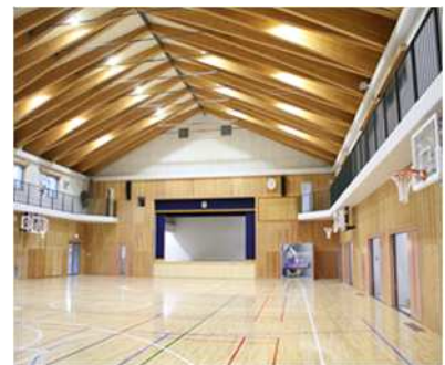
内装の木質化 (松田町立松田小学校体育館棟)
