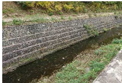
(生態系に配慮した河川の整備 (相模原市))
