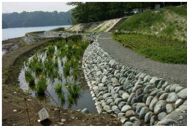
(三井地区植物浄化施設)
