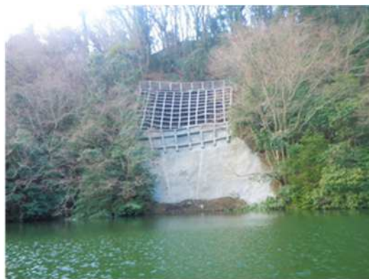
(津久井湖崩落防止工事)
