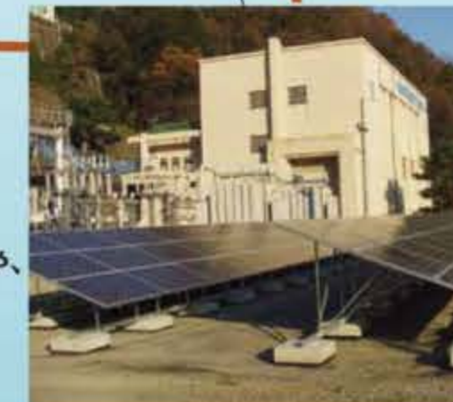
津久井発電所
