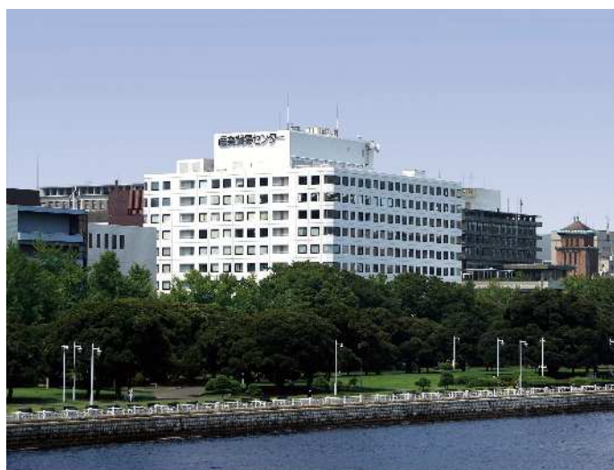
【産業貿易センタービル】
