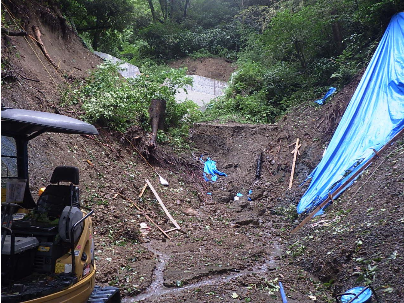
令和元年9月8日 台風15号 通過後の状況 R1.9.9撮影 (右岸及び上流より土砂及び根株が滑落)
