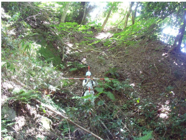
①溪岸侵食の状況
