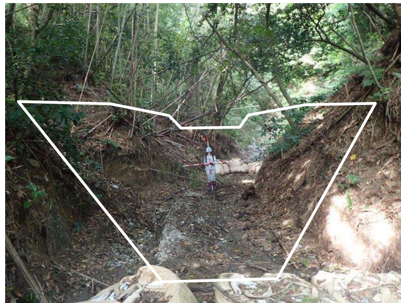
②No1谷止工の施工位置
