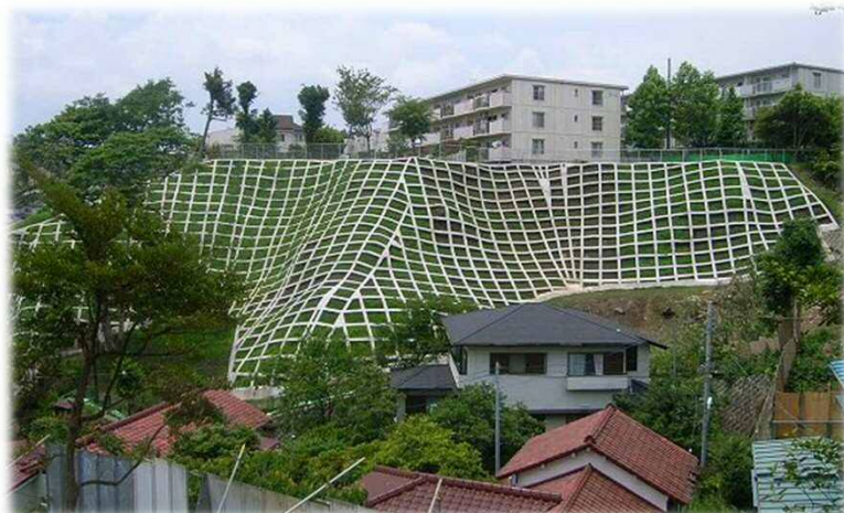
ハード対策の例 法枠工
