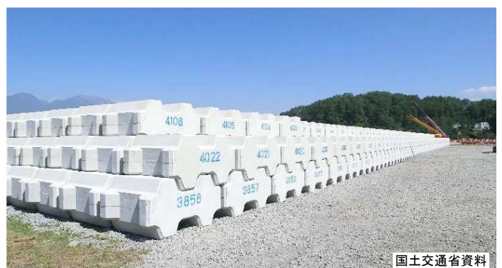
緊急減災対策砂防のために備蓄されたコンクリートブロック（浅間山の事例）
