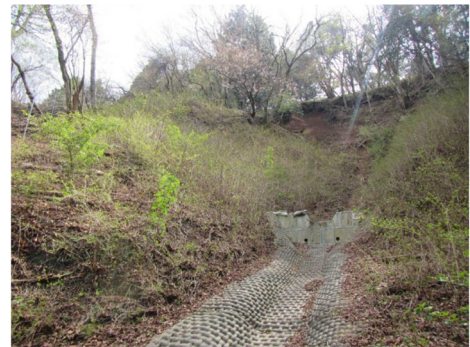
遅速緑化工施工後 3年経過した法面 (秦野市丹沢寺山)
