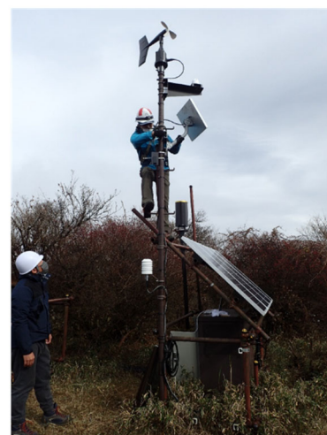
大気気象観測施設の改修状況 (丹沢山)
