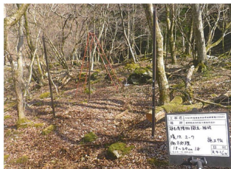
既設植生保護柵の点検・補修後の状況 (清川村)
