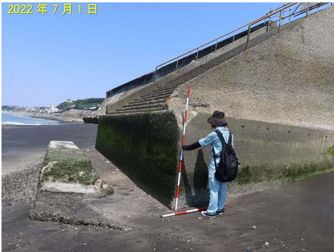
写真-7 駐車場から海浜へ降りるための階段の先にできた落差
