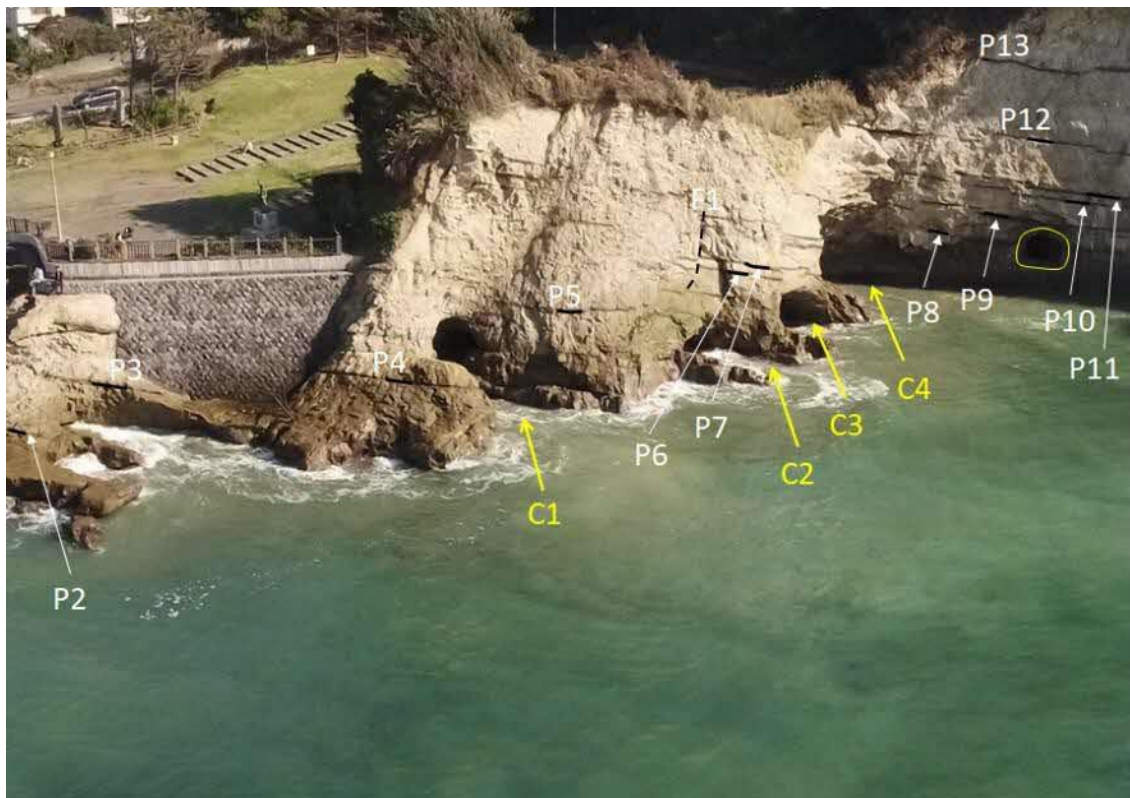
図-3 海食崖西端部（区域 b）の斜め空中写真
