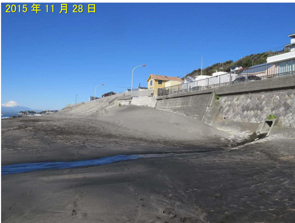
写真-6 侵食前の排水管出口状況
