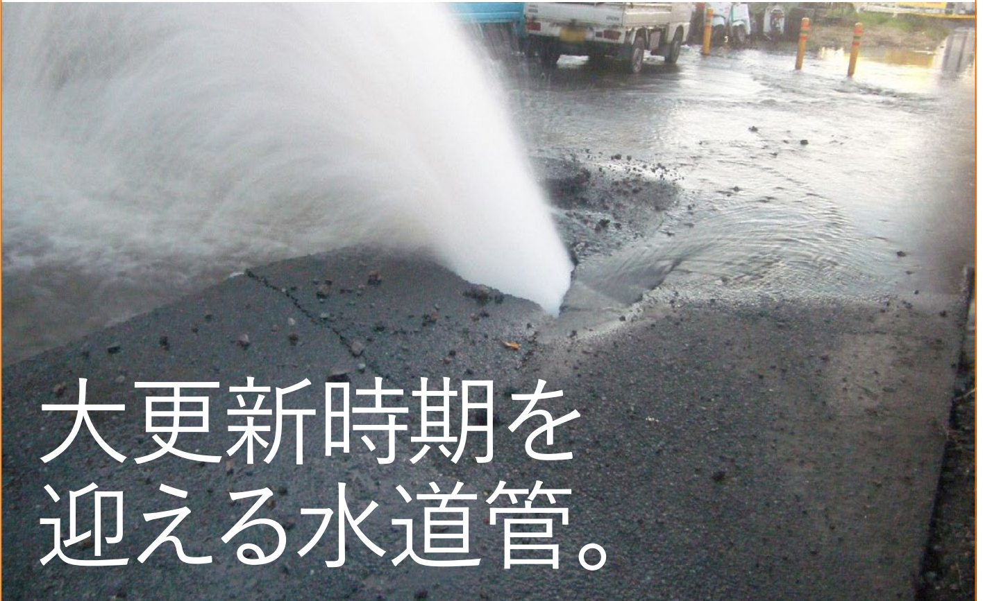
▲茅ヶ崎市内における口径600mmの水道管の老朽化による漏水事故
