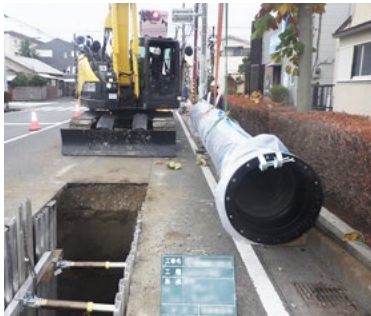
耐震継手管の埋設工事
