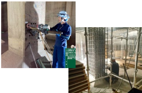
配水池内での工事
