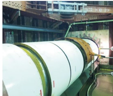
シールド工法による初期掘進工事
