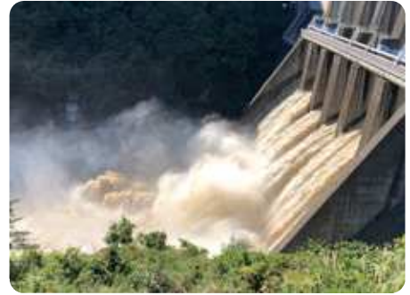
城山ダムからのゲート放流
