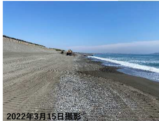
図4.8 2021年度の養浜工事の状況
