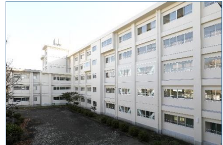
鉄骨ブレース等による耐震化工事後の校舎
