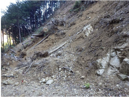
水源林の基盤の整備
