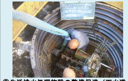
⑧生活排水処理施設の整備促進（下水道・浄化槽） 道路を開削せず、トンネル状に掘削した穴に管を通す工法により下水道管を敷設した。（相模原市緑区）
