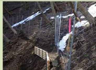
③土壌保全対策 植生保護柵や丸太柵を組み合わせて土壌保全対策を行った。（伊勢原市）
