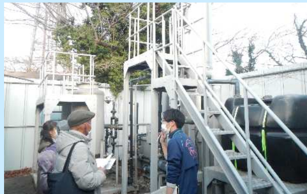
地下水保全対策事業（秦野市） <地下水浄化施設を視察>
