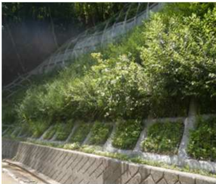
無種子の厚層客土吹付工施工地
