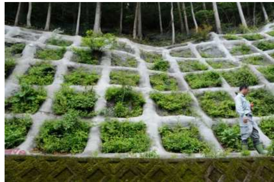
飛来種子捕捉マット施工地
