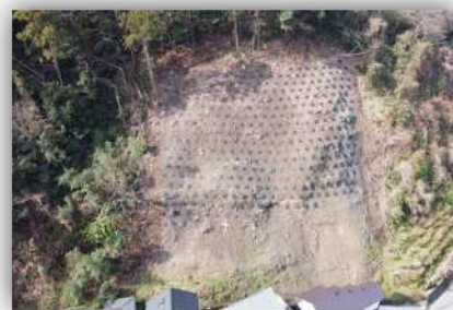
景観等に配慮した防災工事の実施 (鎌倉市大町)
