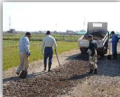
地域ぐるみで実施する農道の補修作業 (伊勢原市)
