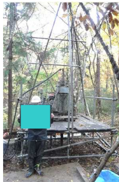
調査ボーリング
