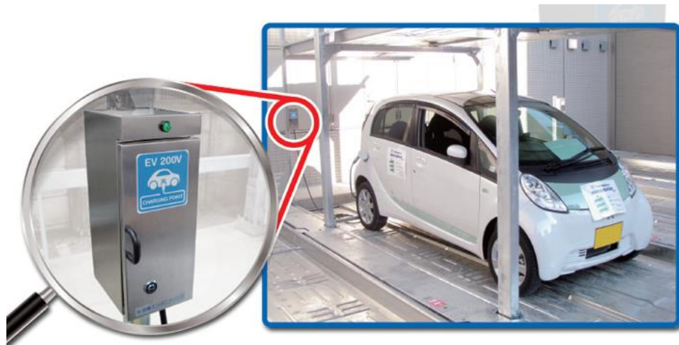
機械式駐車場への充電器設置例 株式会社IHI扶桑エンジニアリングHPより
