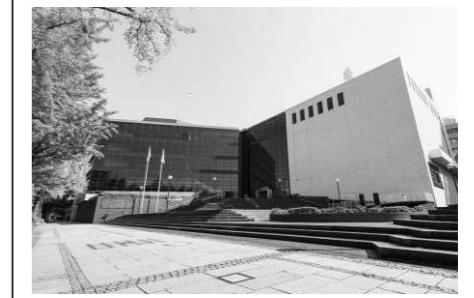
神奈川県民ホール外観
