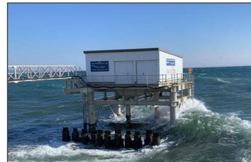
環境省「平成30年度CO2排出削減対策強化誘導型技術開発・実証事業」 平塚波力発電所（※2022年2月に撤去済み）
