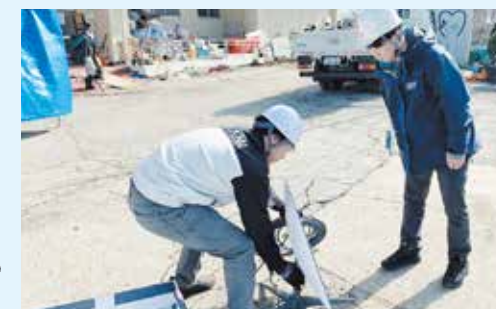
能登半島避難所での衛星通信システム設置の様子 (写真提供: KDDI(株))
