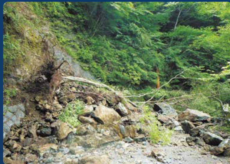
相模原市緑区の土砂崩れ(令和6年6月)
