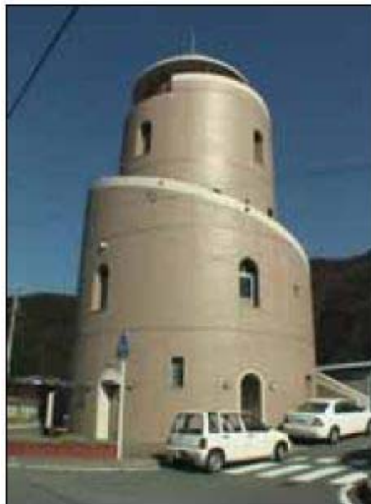
図5.10 避難ビル：錦タワー（三重県）
