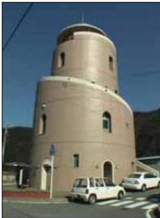
図5.6 避難ビル：錦タワー（三重県）
